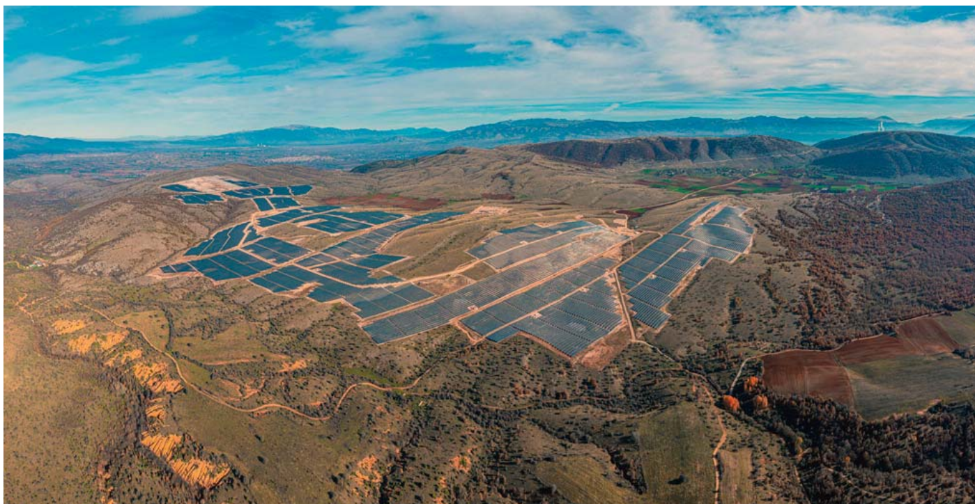
Η HELLENiQ ENERGY πρωτοστατεί στις ενεργειακές εξελίξεις, με έργα αιχμής όπως το πάρκο Φ/Β στη Κοζάνη
