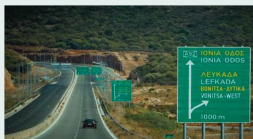
Αρχές Φεβρουαρίου δόθηκε στην κυκλοφορία και το τελευταίο τμήμα Βόνιτσα-Δρυμός του άξονα Άκτιο-Αμβρακία
