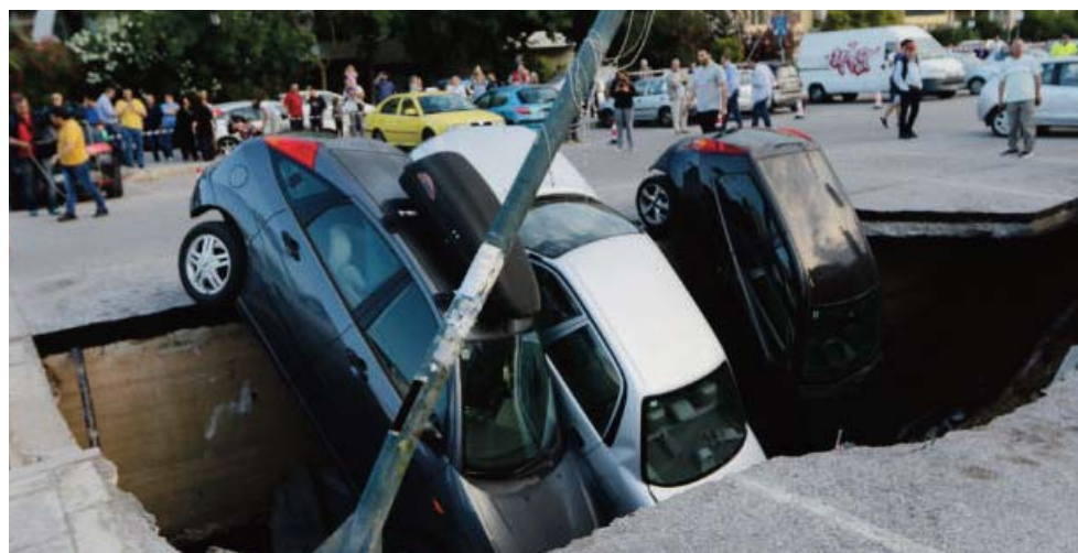
Η τρύπα αυτή κατάπιε τρία αυτοκίνητα, ενώ ένα τέταρτο πρόλαβαν και το έβγαλαν εγκαίρως
