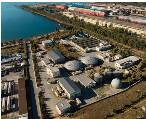
Κέντρο Επεξεργασίας Λυμάτων Θρασίου
