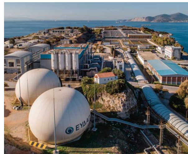
Κέντρο Επεξεργασίας Λυμάτων Ψιττάλειας
