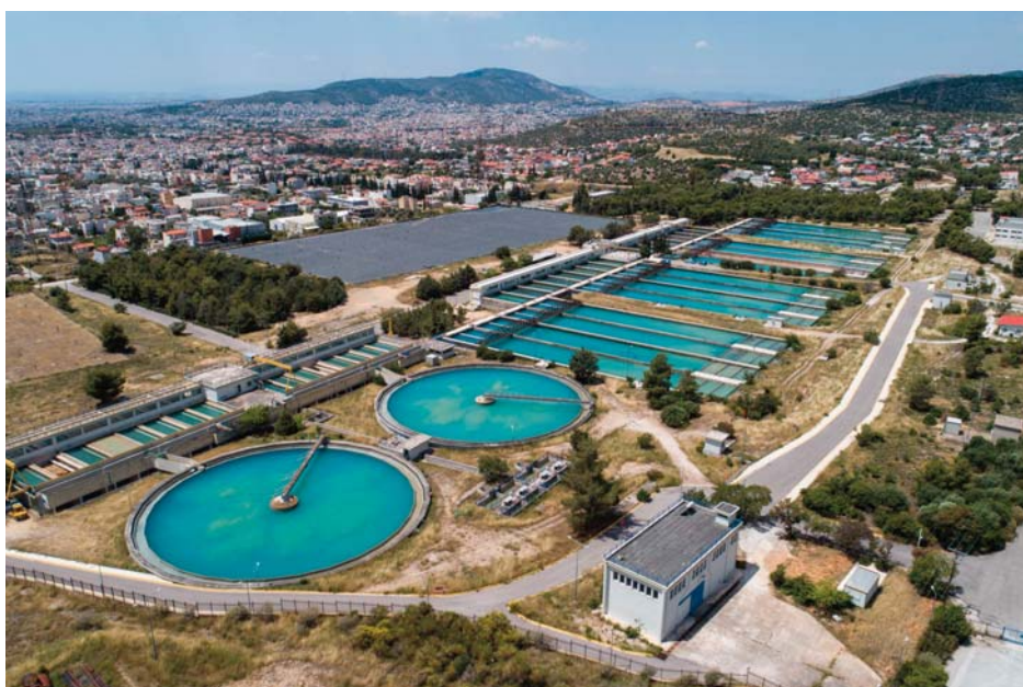
Μονάδα Επεξεργασίας Νερού Μενιδίου
