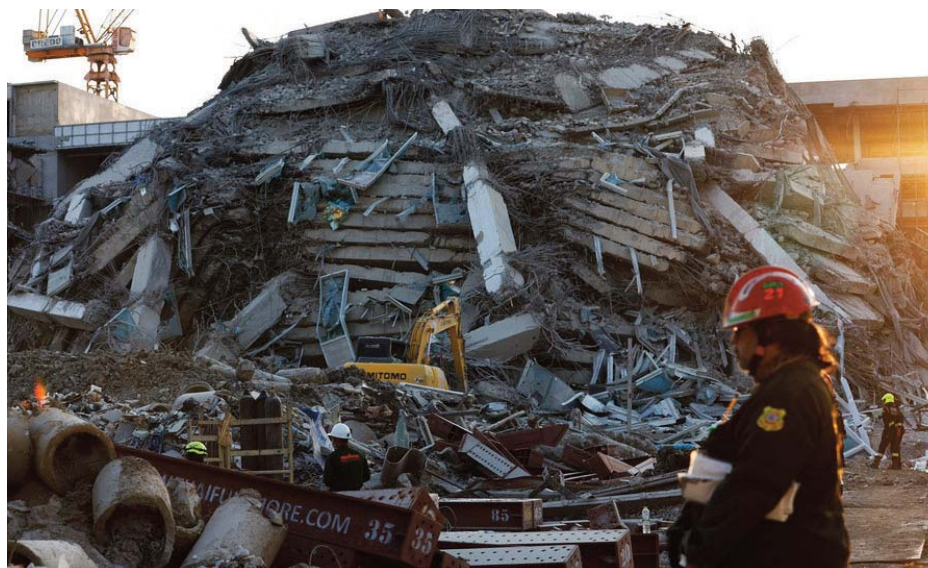
Άγνωστος ο αριθμός των νεκρών, σε κατάσταση έκτακτης ανάγκης η χώρα - Ισοπεδώθηκαν ουρανοξύστες ακόμη και στη γειτονική Ταϊλάνδη - Ο σεισμός έγινε αισθητός μέχρι τη Δυτική Κίνα
